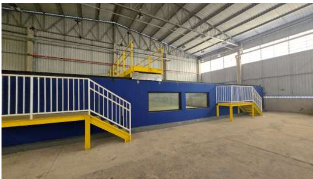
Figura 1: Vista lateral do tanque
